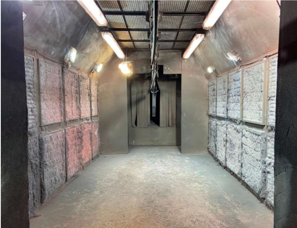
Figura 4 – Cabine de Pintura, vista interna da cabine.
